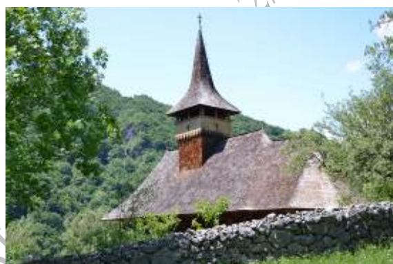
Fig. 2. Mănăstirea din cătunul Sub Piatră
