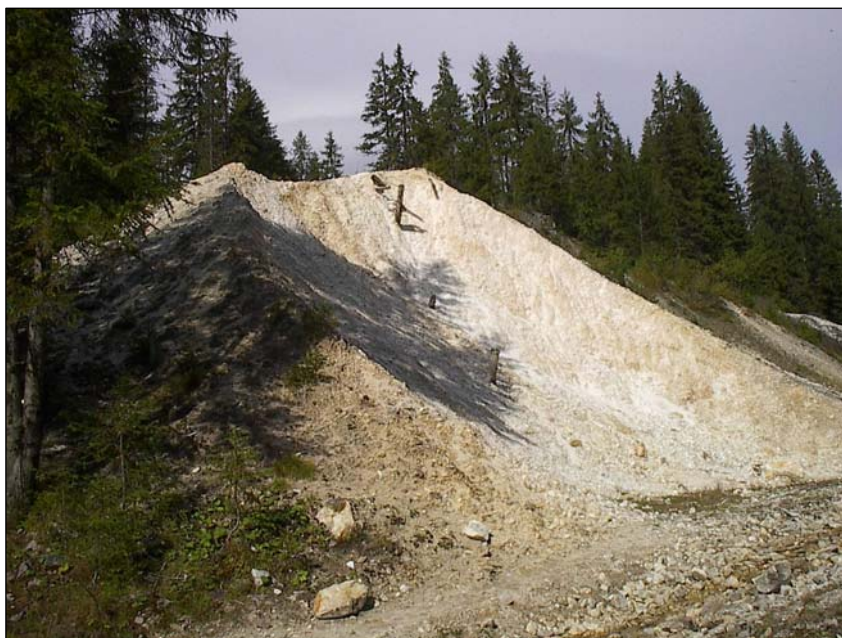
Fig.2. Halda de steril de la galeria de prospectare minieră
